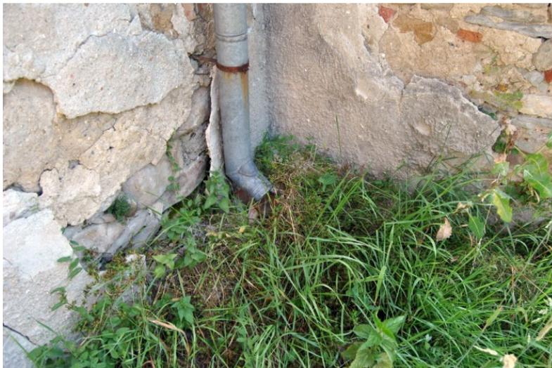
Abb. 28 – Fehlende Anschluss zum Ablauf des Regenwassers vom Sockel weg
