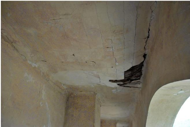
Abb. 31 – Nordempore, außen, Schäden an der Decke
