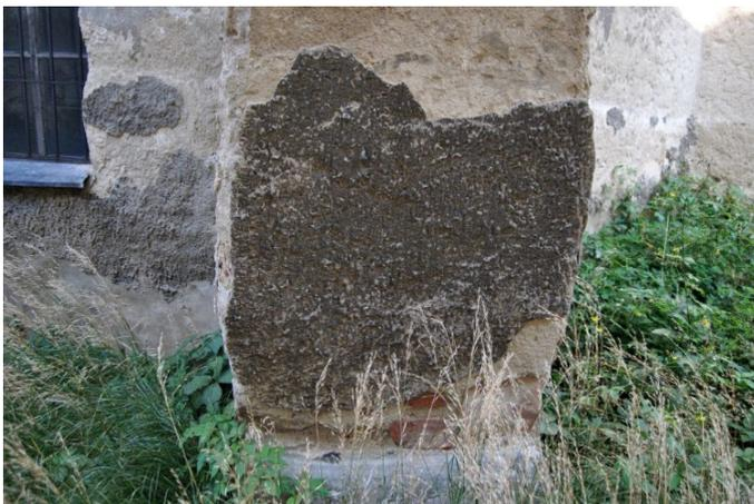
Abb. 22 – Stützpfeiler, Zementputz
