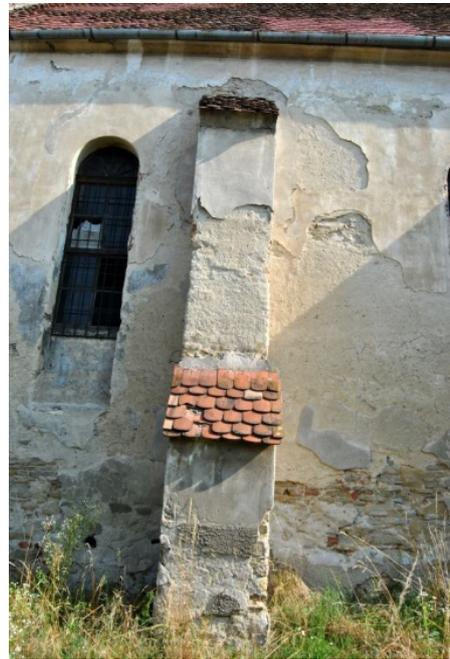
Abb.20 – Südfassade, Putzschäden,
