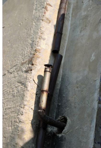
Abb. 24 – Chor, Süd, defektes Fallrohr
