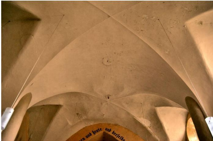
Abb. 08 – Langhaus, Gewölbe, Putz- und Farbschäden
