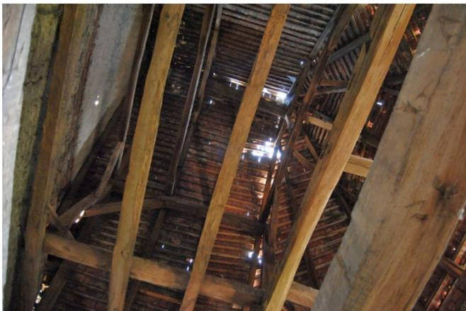
Abb. 36 – Dach, Chor, innen, defekte Deckung
