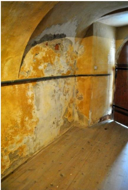
Abb. 09 – Langhaus, unter Westempore, Feuchtigkeitsschäden
