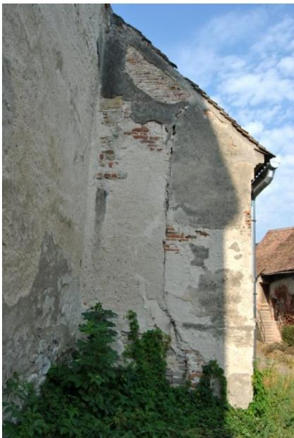
Abb. 25 – Nordempore, außen, Fugenriss
