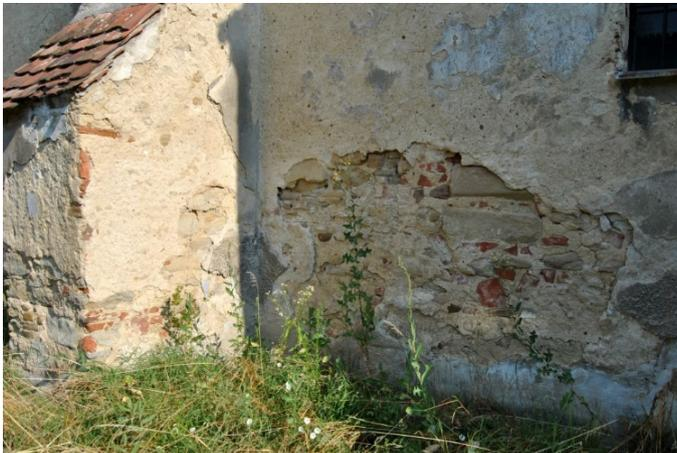
Abb. 21 – Südfassade, Putzschäden,
